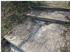
Haut de l'escalier
