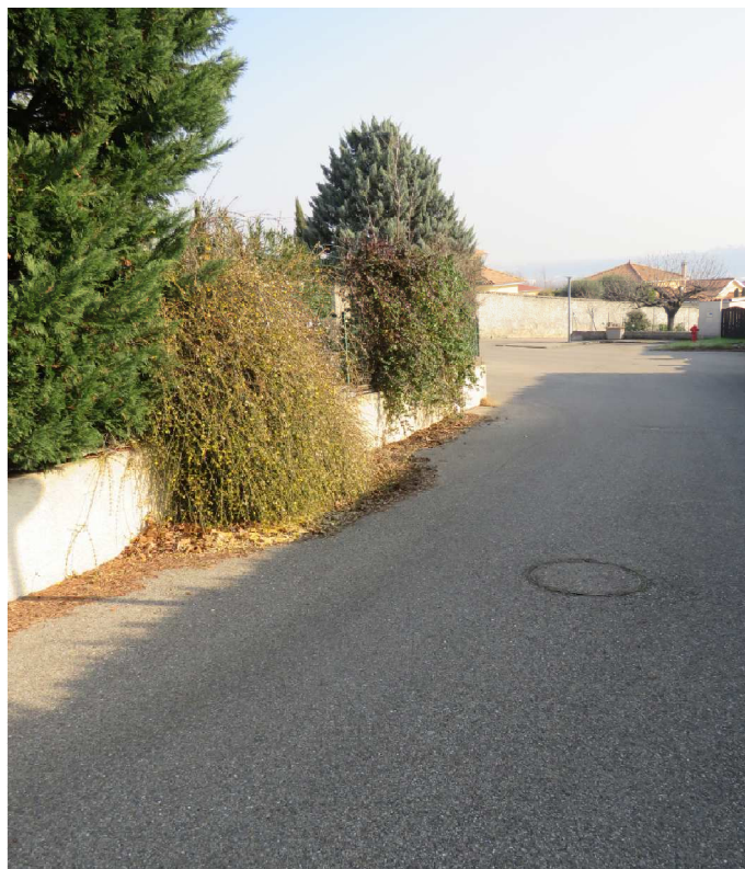
N°10 : amoncellement de végétaux au droit du muret de clôture du lot n°4 participant à la dégradation du béton bitumineux
