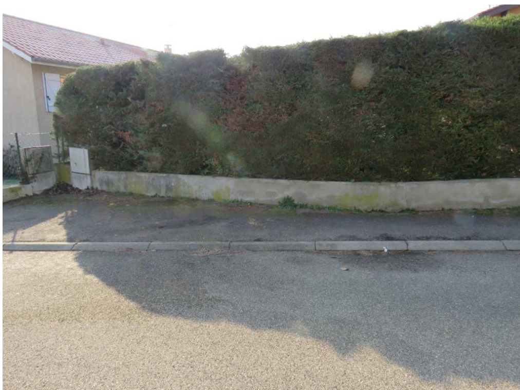
N°3 : amoncellement et développement de végétaux au droit du muret de clôture de lot n°46 participant à la dégradation du béton bitumineux
