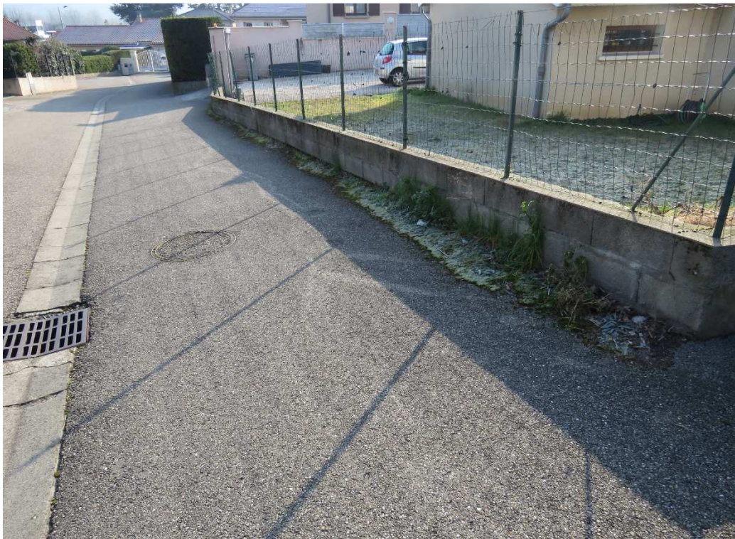
N°3 : amoncellement et développement de végétaux au droit du muret de clôture de lot n°46 participant à la dégradation du béton bitumineux
