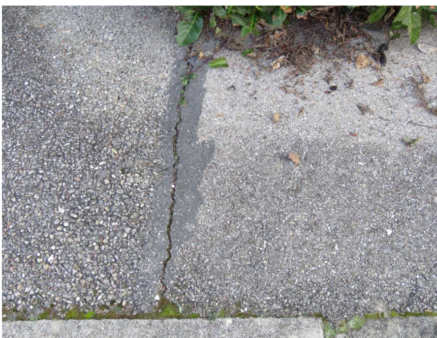
N°17 : fissure sur chaussée de retrait le long d'une reprise de réalisation d du béton bitumineux au droit des lots n°29 et n°30 (voirie de raccordement entre les lots n°29, 30, 23 et 24) - Ouverture de 2 a 4 mm.
