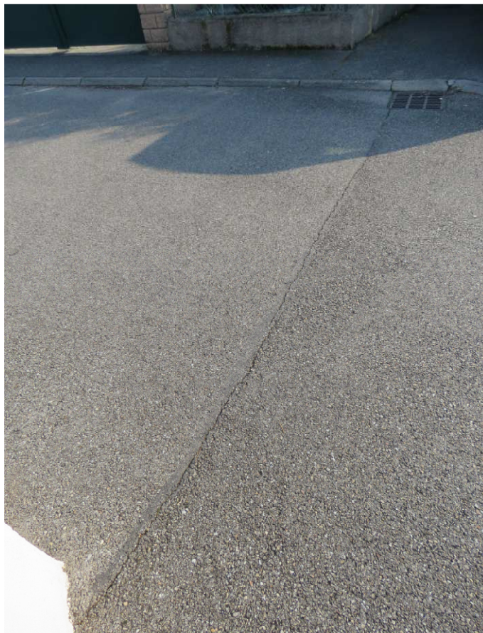
N°17 : fissure sur chaussée de retrait le long d'une reprise de réalisation d du béton bitumineux au droit des lots n°29 et n°30 (voirie de raccordement entre les lots n°29, 30, 23 et 24) - Ouverture de 2 a 4 mm.
