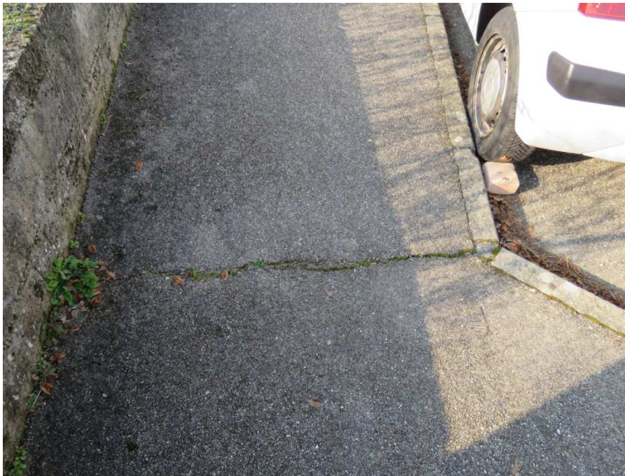
N°25 : fissure de retrait le long d'une reprise de réalisation du béton bitumineux le long du parking au droit du lot n°10 - Ouverture de 1 à 2 mm
