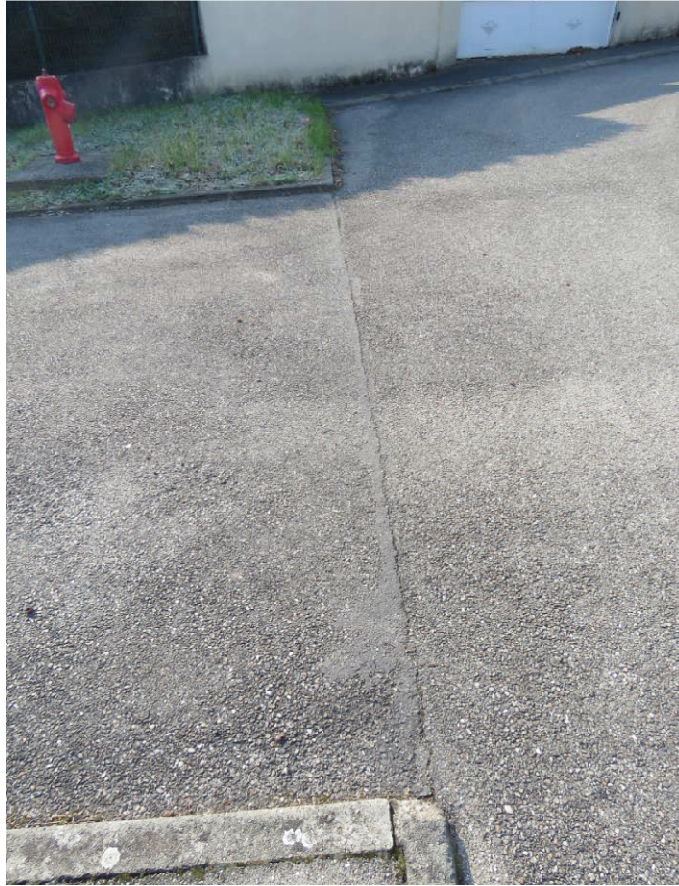
N°25 : fissure de retrait le long d'une reprise de réalisation du béton bitumineux le long du parking au droit du lot n°10 - Ouverture de 1 à 2 mm
